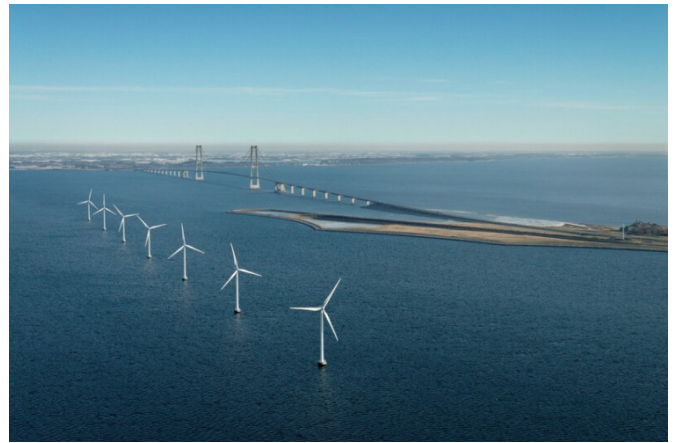
Foto: Arquivo Vestas/Divulgação Parque eólico offshore nas águas da Dinamarca, ao norte da Europa
